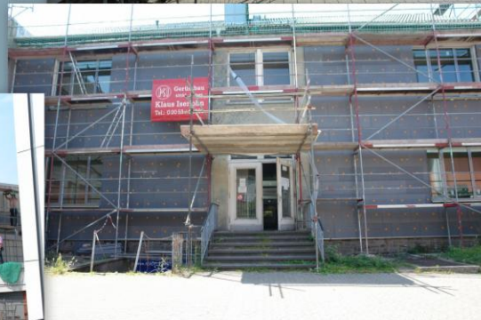
Baustelle Gebäude 1 und 2
